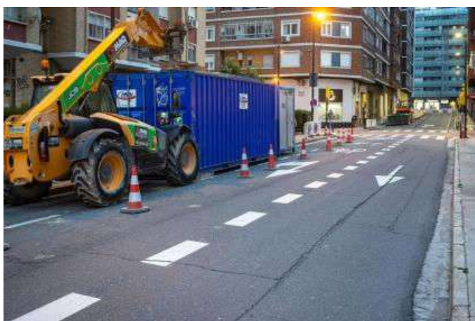
Una de las zonas en las que el Ayuntamiento va a intervenir | Foto: DANIEL MARCOS
