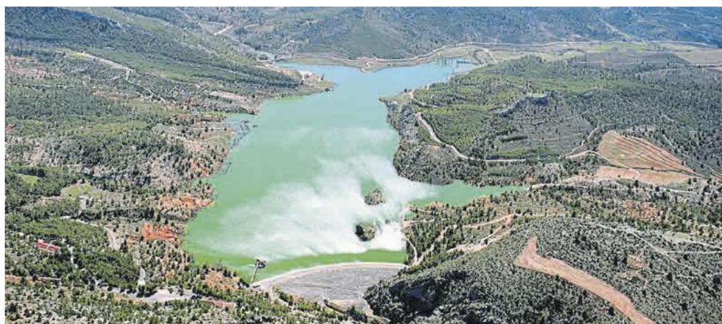
Vista aérea mediante dron de la presa de embalse de la MCT en Nerpio (Albacete), pieza clave para el abastecimiento en la Región de Murcia.
